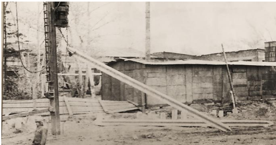
Рис. 3. Подготовка к натурным испытаниям железобетонных свай с пазами
